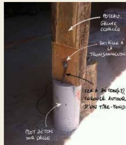
Assemblage poteau / plot-béton
