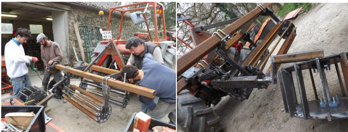
Un chantier collectif s'est déroulé dans l'atelier du cfppa de Kerliver le 16 février 2015
