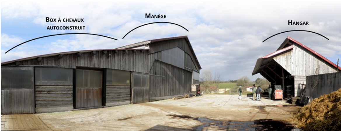
△ Vue des bâtiments.
