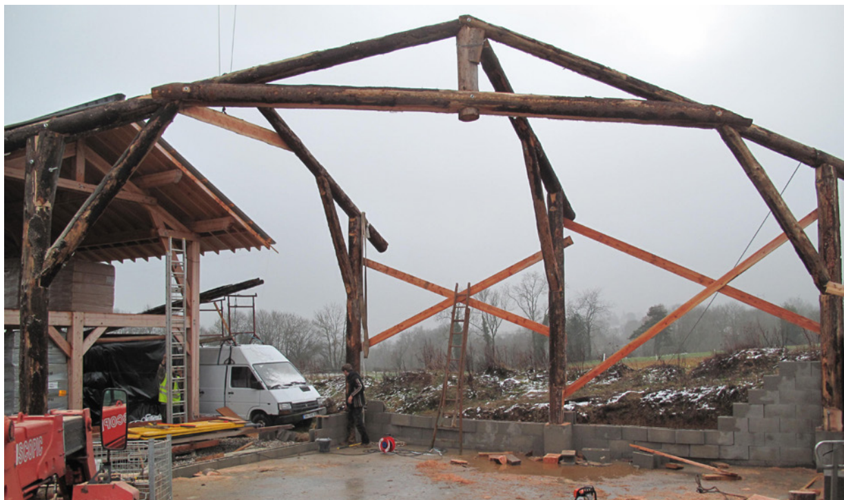
△ La partie en angle du bâtiment est en place : les contrevents et les demi-charpentes posées sur la noue stabilisent cette partie de la structure.
