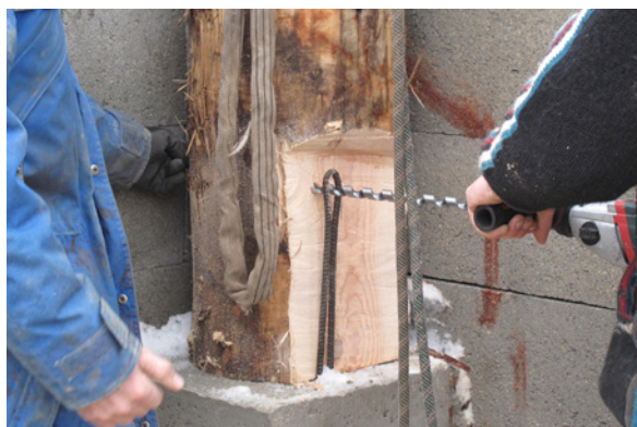
△ Ancrage de la charpente aux pieds.
