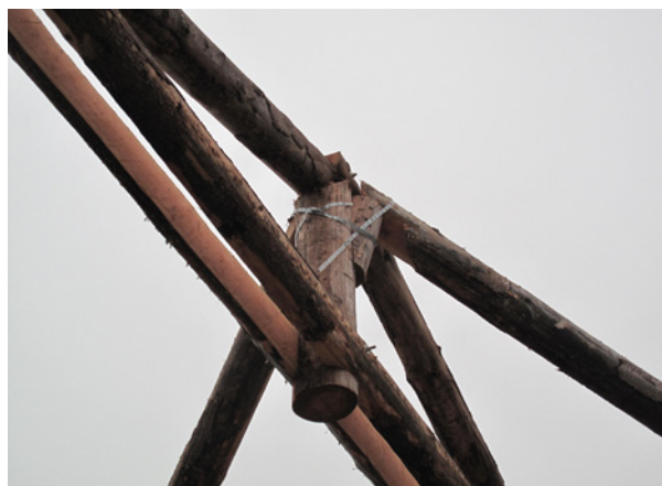
▲ Les demi-charpentes reposent sur deux corbeaux et sont fixées par une bande perforée.
