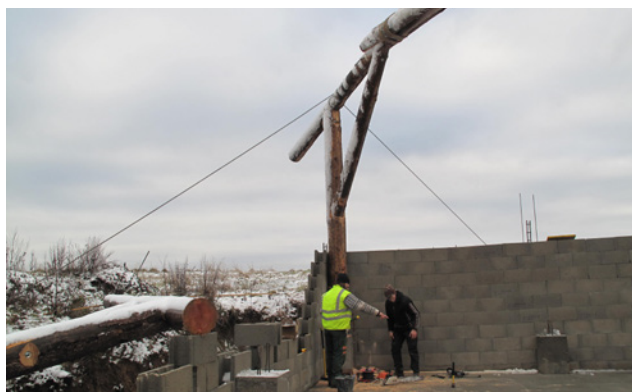
△ Mise en place du système de cordes qui stabilisent provisoirement la charpente qui est une noue (voir glossaire).
