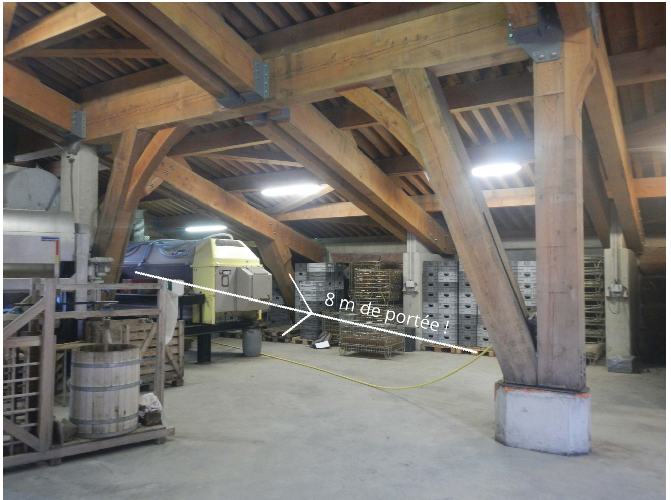
Pas de lamellé collé dans le chai, mais pas de poteau au milieu non plus !
