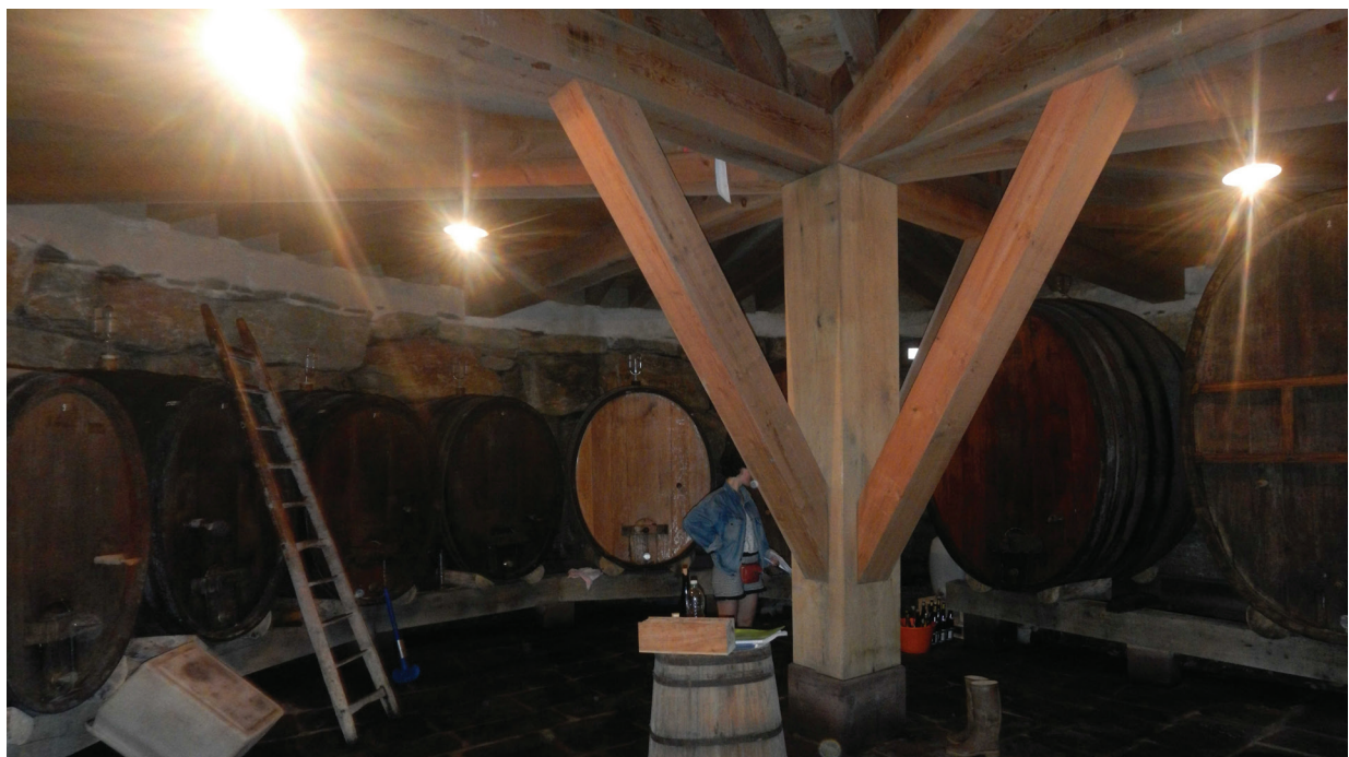
Vues de la cave : ceinture et structure béton-armé, enrochement, pilier central en bois
