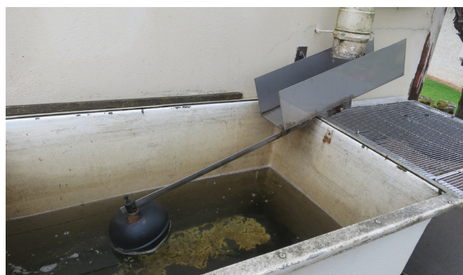
La cuve-tampon et la jauge en sortie de gouttière
