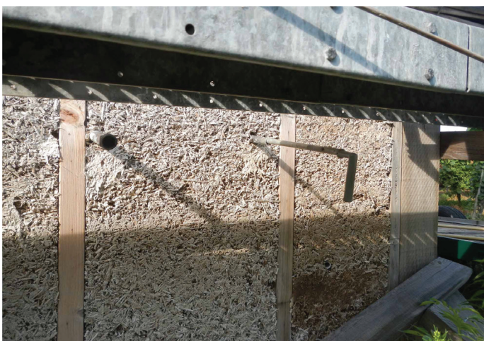
Une paroi isolée avec du miscanthus
