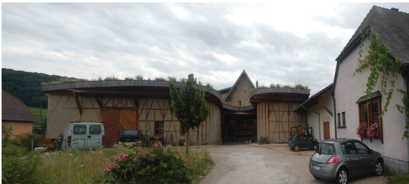
Vue d'ensemble du nouveau bâtiment depuis la cour, accolé au bâtiment existant
