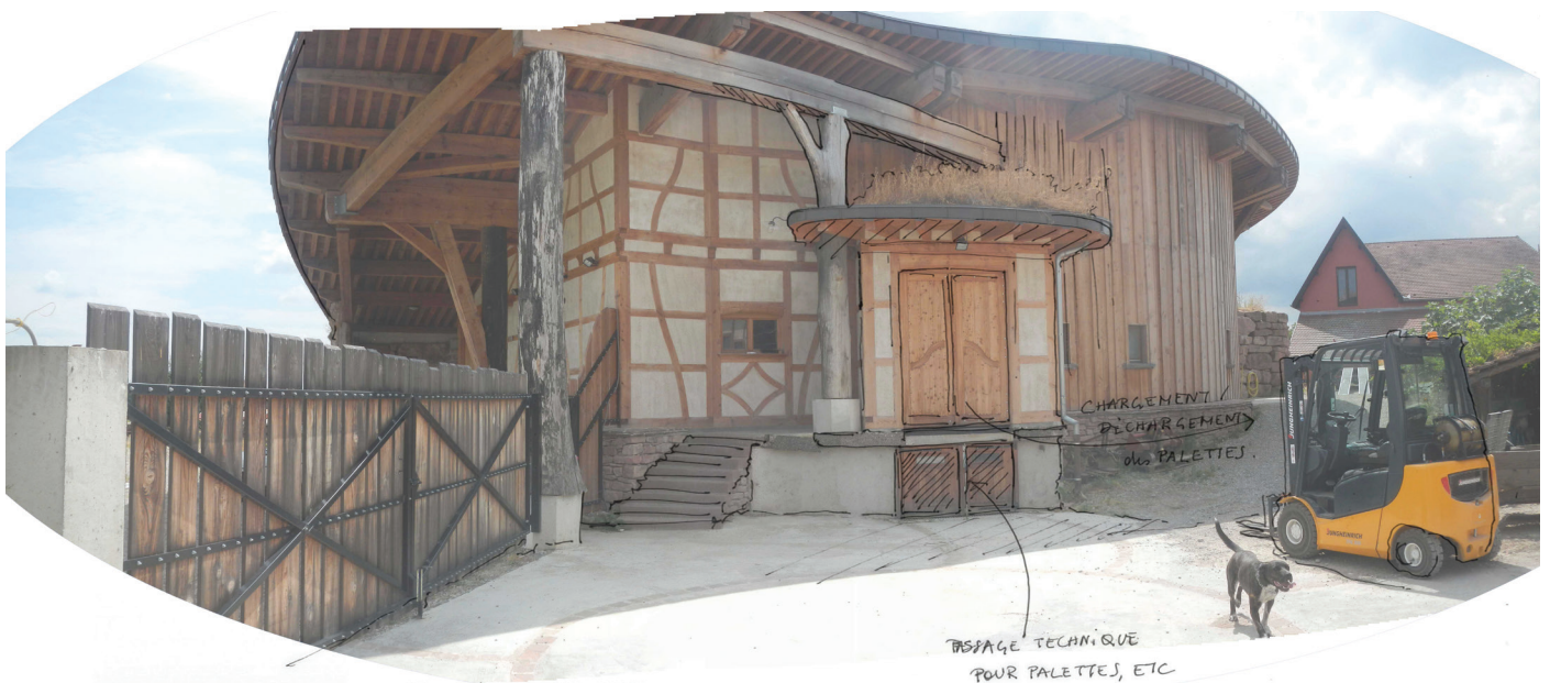
Vue du nouveau bâtiment depuis la cour
