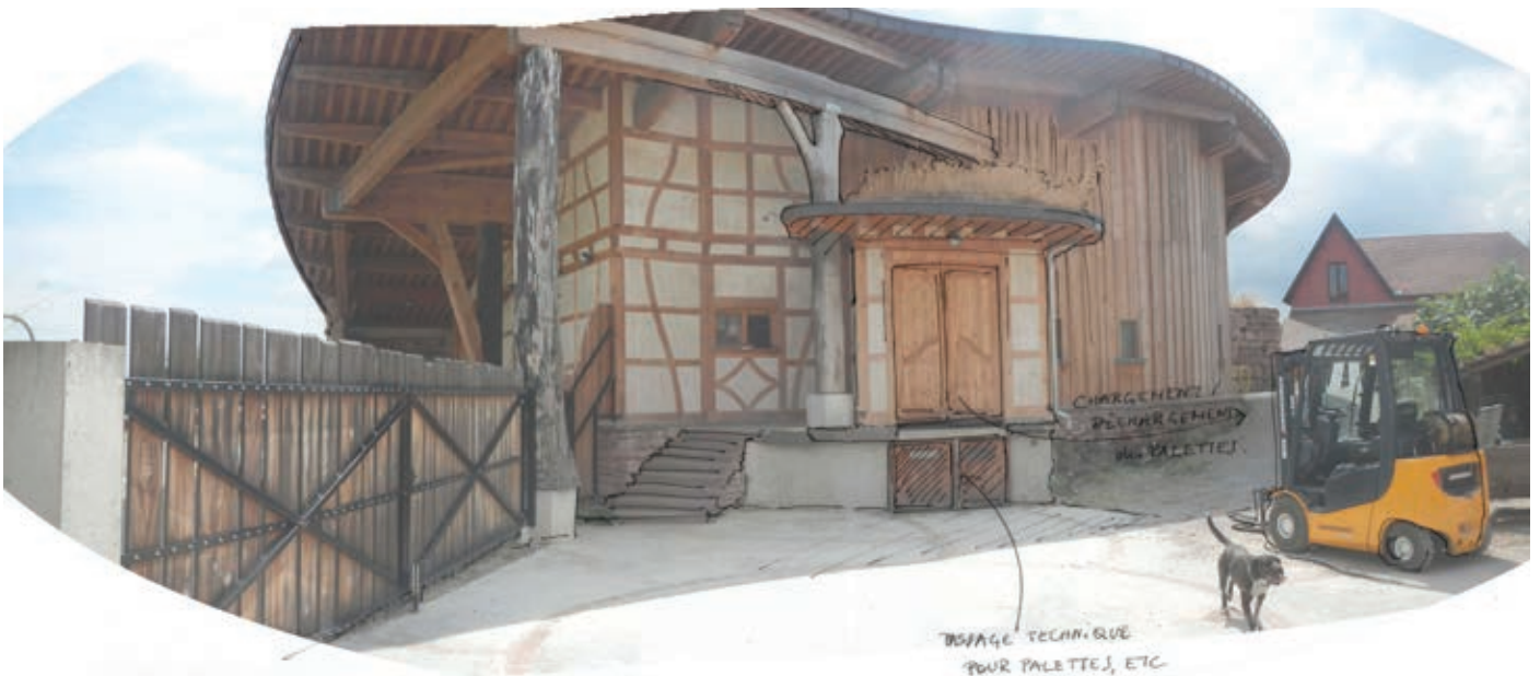
Vue du nouveau bâtiment depuis la cour
