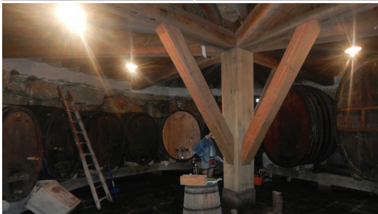
Vues de la cave : ceinture et structure béton-armé, enrochement, pilier central en bois
