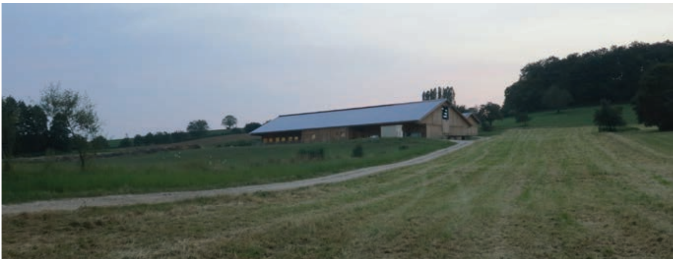
Vue d'ensemble du nouveau bâtiment
