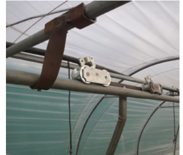
△ Détail roulement.
