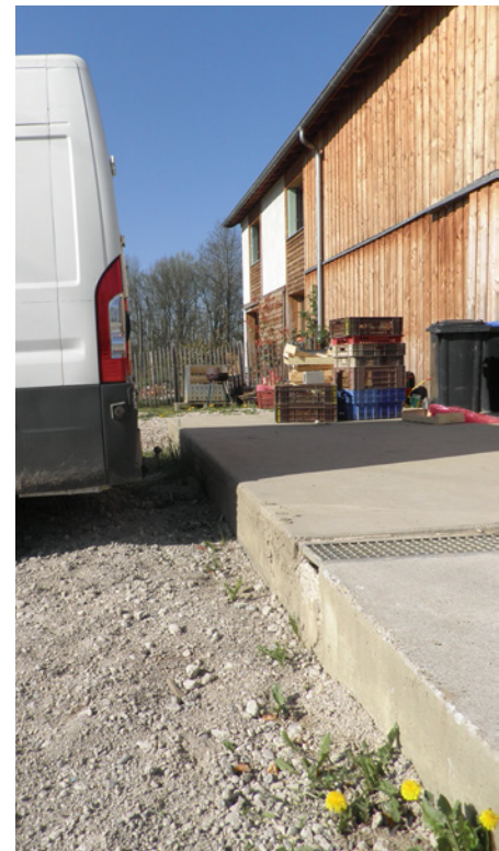
▽ Détail du quai à hauteur du camion.
