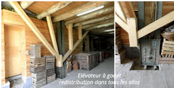
△ Détail de l'élévateur à godet.
