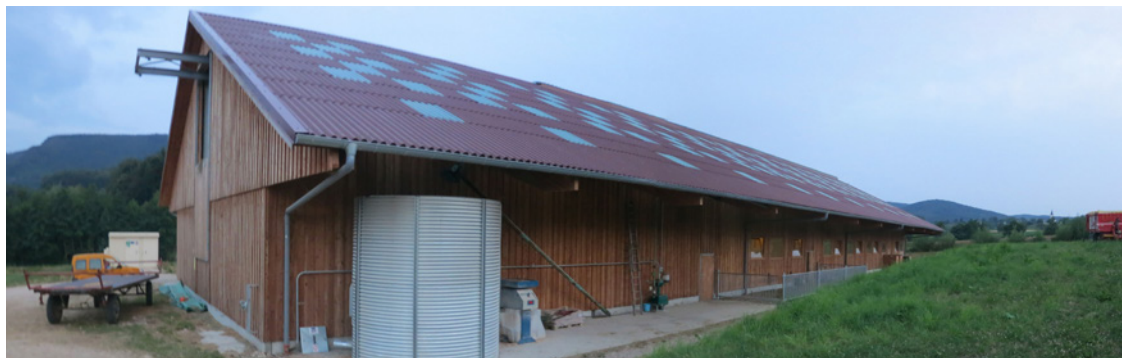
▽ Vue extérieure du bâtiment d'élevage.
