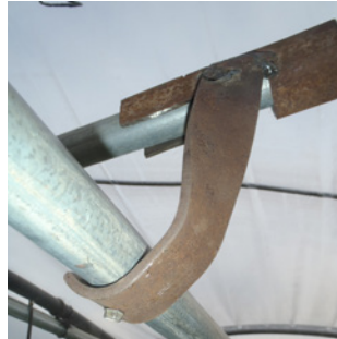
△ Détail pièce pour fixer le rail. ◁ Vue d'ensemble.
