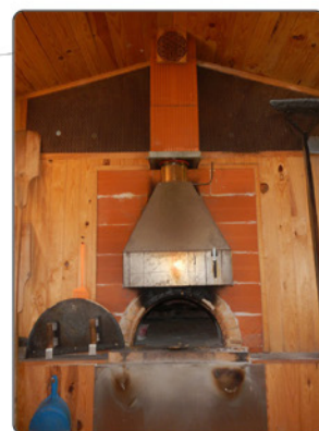
◁ La cheminée du four : briques de récupération soutenues par un tirant métallique. Les grilles à gauche et à droite permettent à la chaleur du four de tourner dans la pièce.
