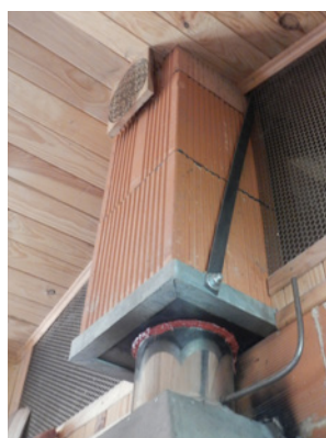
◁ La cheminée du four : briques de récupération soutenues par un tirant métallique. Les grilles à gauche et à droite permettent à la chaleur du four de tourner dans la pièce.
