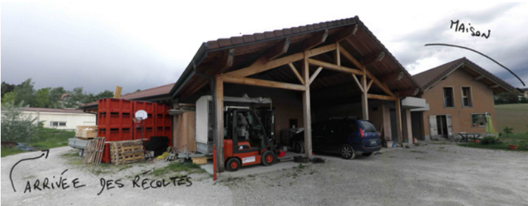
△ Vue d'ensemble : façade sud-ouest.
