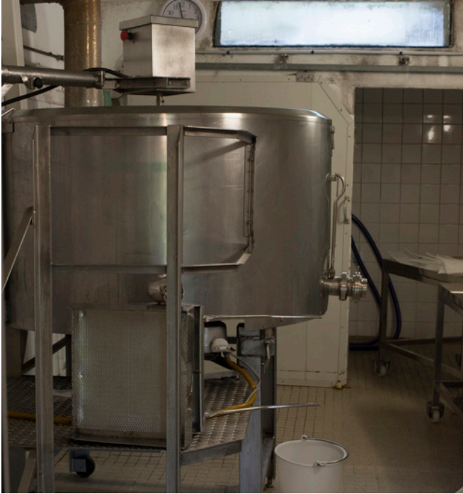
△ La cuve est placée en hauteur, ce qui permet de la vider par gravité et de ne pas écoper le contenu. On accède à la cuve par un escalier qui mène à une petite plateforme sur le côté de la cuve.
