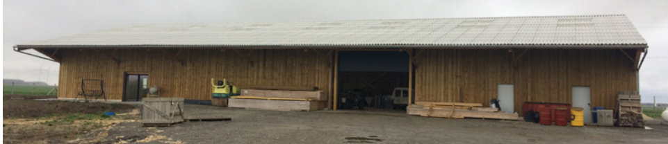
◁ Vue d'ensemble du hangar.
